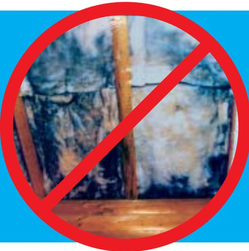
Im Winter diffundiert die Feuchtigkeit der warmen Innenluft in die Wärmedämmung. In dieser Zeit erfüllt die HYGRODIODE die Aufgabe einer Dampfbremse, die darin besteht, schädliche Kondenswasserbildung im Inneren der Konstruktion zu verhindern. Bei wärmegeämmten Dächern, aber auch bei innengeämmten Wänden sind Dampfsperren daher unverzichtbar und in der ÖNORM B 8110 Teil 2 vorgeschrieben.
