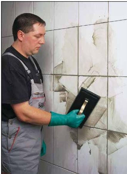
**4** Anschließend wird der Belag (je nach Keramik) z.B. mit Sopro DF 10® DesignFuge Flex, Sopro FlexFuge plus, Sopro Saphir® 5 PerlFuge oder Sopro Brillant® PerlFuge verfugt.
