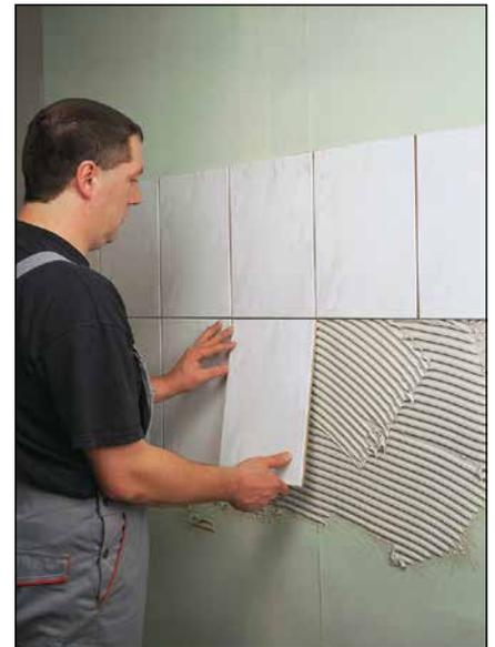
**3** Die Fliesen werden in herkömmlicher Technik z.B. mit Sopro FliesenFestKleber angesetzt.
