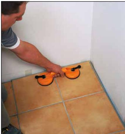
**4** Nach Entfernen der Sockelleisten wird der Fliesenbelag, hier beginnend im Eckbereich, mittels eines Sauggriffes aufgenommen.
