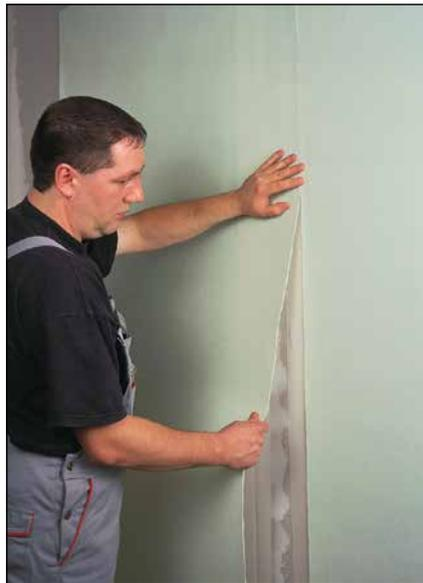
**2** Das zugeschnittene Sopro WE-Vlies wird an den Stößen mittig auf dem Sopro Fixier-Band befestigt.
